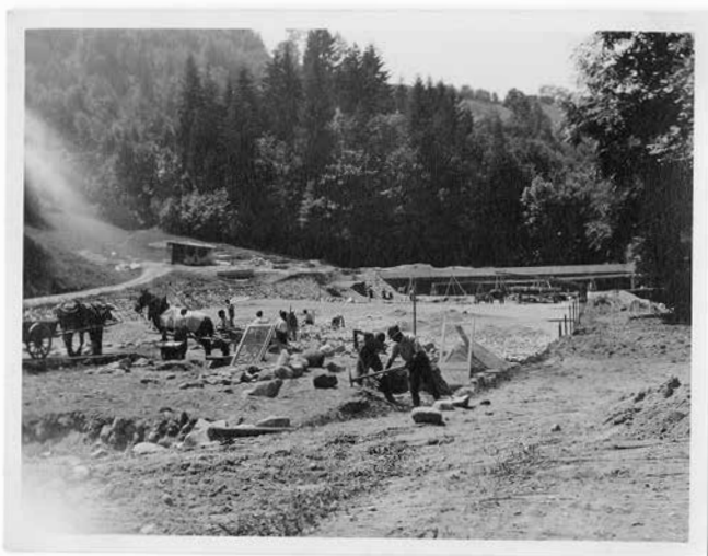
Das Schwimmbad Trogen wurde 1930 eröffnet; das Bild zeigt es im selben Jahr noch als Baustelle.
